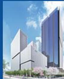
虎ノ門二丁目再開発 2023年11月竣工予定 延床面積約18.1万㎡
