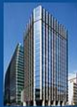
日鉄日本橋ビル 2019年
