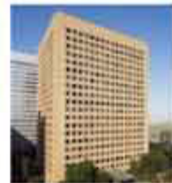
III-9 興和川崎西口ビル
