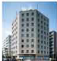
III-6 第44興和ビル
