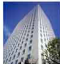
III-8 海老名プライムタワー
