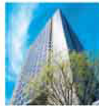
III-2 興和川崎東口ビル
