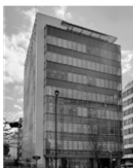
大和茅場町ビル
