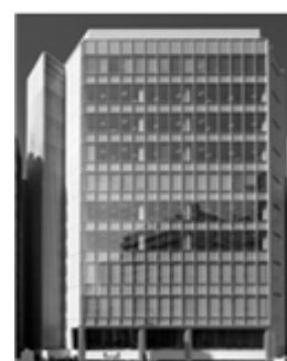
新四curumuビル
