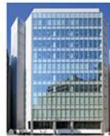
新四curumuビル
