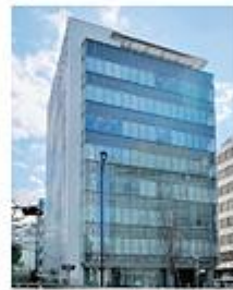
大和茅場町ビル
