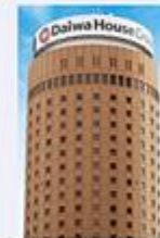
大阪マルビル(大阪第一ホテル)
