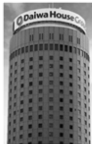
大阪マルビル(大阪第一ホテル)
