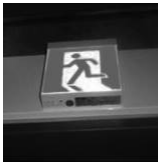
非常用誘導灯
