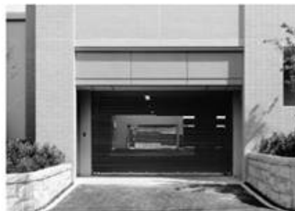
駐車場シャッターゲート (プライムメゾン高見)
