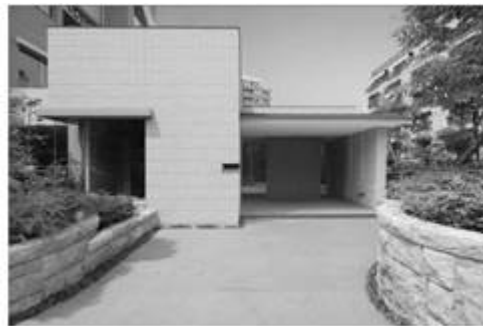
外構の石積み (プライムメゾン高見)
