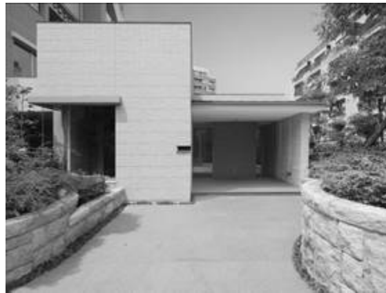
外構の石積み (プライムメゾン高見)
