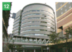
12 キャンナルシティ・ビジネスセンタービル
