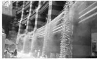
●キャナルシティ博多 夏季の直射が強い期間には、ミスト発生装置を設置
