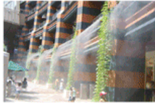
●キャナルシティ博多 夏季の日射が強い期間には、ミスト発生装置を設置
