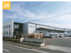
高橋ロジスティクスセンター
