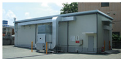
門真物流センター 危険物倉庫
