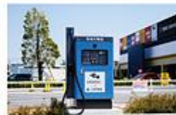
電気自動車用急速充電器の設置 (三井ショッピングパーク ららぽーと磐田)
