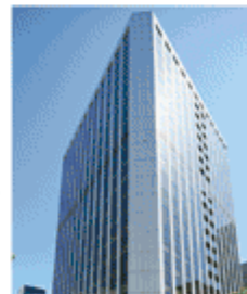
トレードピア流通橋(蔵地) 大阪府大阪市中央区
