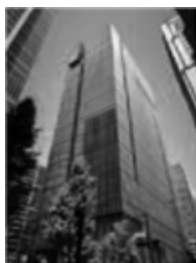
大手町タワー（底地）
