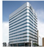
事B-5 新横浜第二 センタービル
