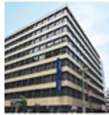
高B-12 東京建物本町ビル
