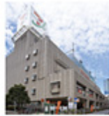
高B-4 JPR武蔵小杉ビル
