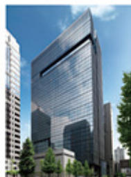
大手町タワー（底地） （東京都千代田区）
