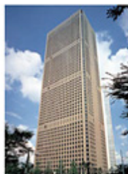
新宿センタービル （東京都新宿区）
