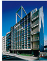
事A-2 兼松ビル別館
