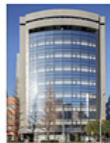
事A-15 南麻布ビル
