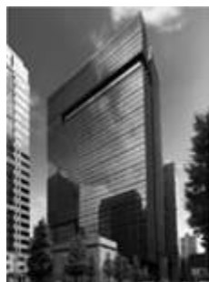
大手町タワー(底地) (東京都千代田区)
