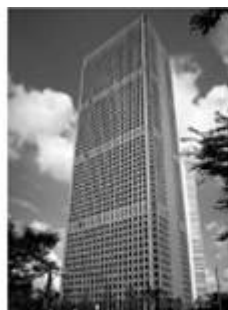
新宿センタービル (東京都新宿区)
