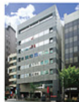
事A-9 JPR市ヶ谷ビル
