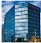
高B-11 新高城南 センタービル
