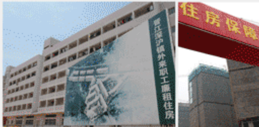
写真左:福建省晋江市の公共住宅 写真右:江蘇省南京市の公共住宅建設現場
