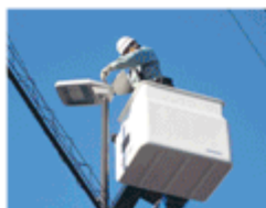
道路照明灯保守
