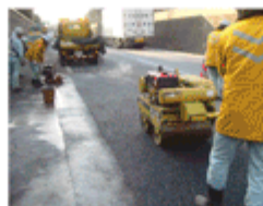
維持修繕工事
