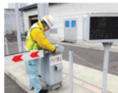
高速道路通信設備保守
