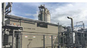
コージェネレーションシステム
