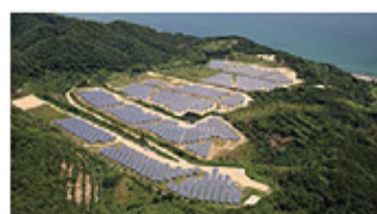
再生可能エネルギー発電所の所有・運営・売電 ※淡路佐野メガソーラー発電所
