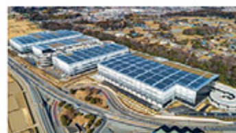
太陽光発電システム
