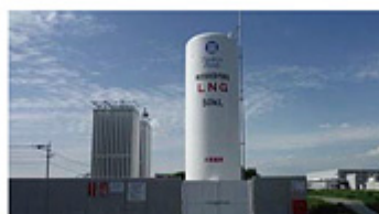
LNGサテライトシステム
