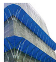
くさび緊結式次世代シート朝顔
