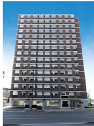
LIBTH平成タワー
