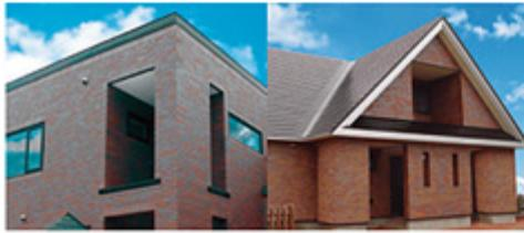
金属サイディングと同様の下地の断熱プレートにタイルを引っ掛けてボンドで接着する「乾式工法」を採用し、取り付けが容易で優れた施工性を発揮します。
