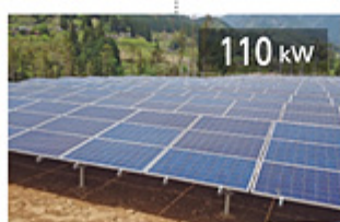
宮崎県 ▶高千穂太陽光発電施設
