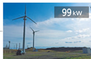
北海道 ▶松前小型陸上風力発電施設
