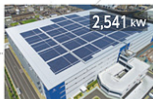
大阪府 ▶大阪大正区物流センター太陽光 発電施設
