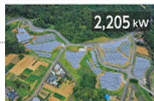
静岡県 ▶伊豆の国太陽光発電施設
