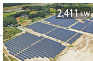
宮城県 ▶山元第一太陽光発電施設
