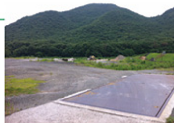
〈安定型最終処分場〉
