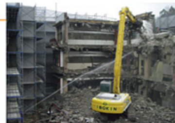
〈ビル解体工事〉
