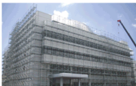
次世代足場「SPS」を使用した施工現場
