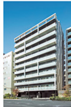
アルテシモシェルト (東京都江東区深川) 外観
