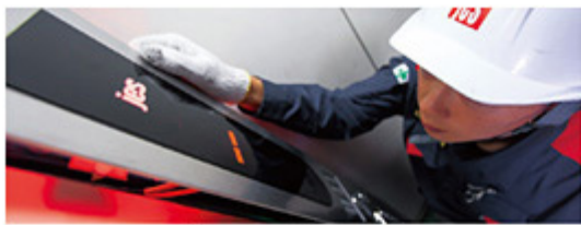
(リニューアル工事の様子)
