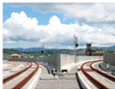
JR大分高架軌道新設
