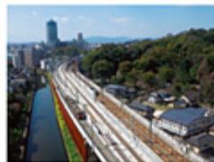
熊本駅付近連続立体交差化工事
