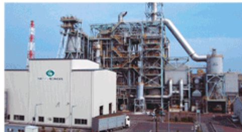
市原グリーン電力発電所 外観
