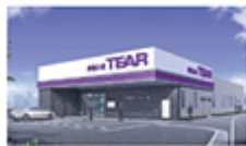
「ティア下之一色」 平成29年10月開設（名古屋市守山区）
