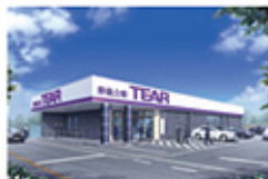
平成25年8月 「ティア瑞ヶ谷」(埼玉県川口市)
