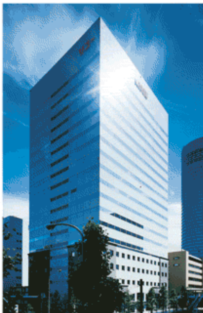
常和新横浜ビル 新横浜駅至近・地上20階・地下3階・延床面積40,000㎡
