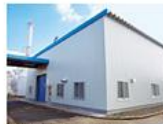
郡山工場第三工場建屋
