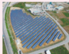
田老太陽光発電所 (岩手県宮古市) (注2)
