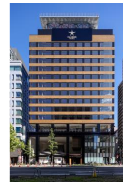
▲ カンデオホテルズ 大阪心斎橋 (2023年9月竣工)
