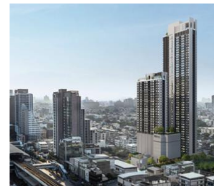
▲ リファレンスPJ (2024年竣工予定)
