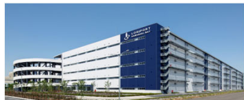
ロジポート川崎ベイ ・ 2021年3月期売却
