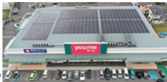
▲太陽光発電パネルが設置された「ゆめマート日田」
