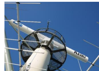
欧州で稼働中の VTSS用レーダー
