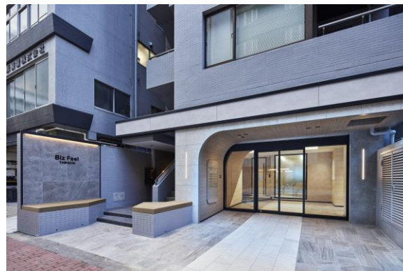
駐車場をオフィススペースにコンバージョン
