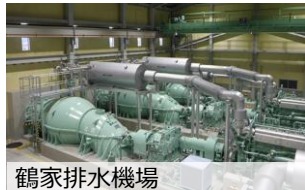
鶴家排水機場 宮城県石巻市
