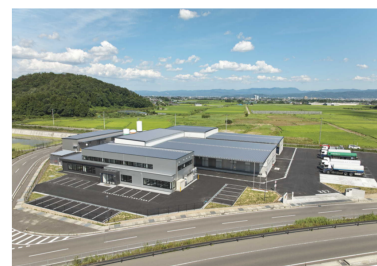
(仮称)高圧ガス工業(株)福島高圧ガス流通センター新築工事(福島県)
