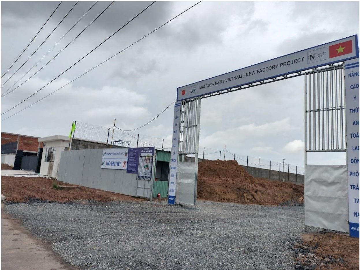
(新工場建設現場の様子)
