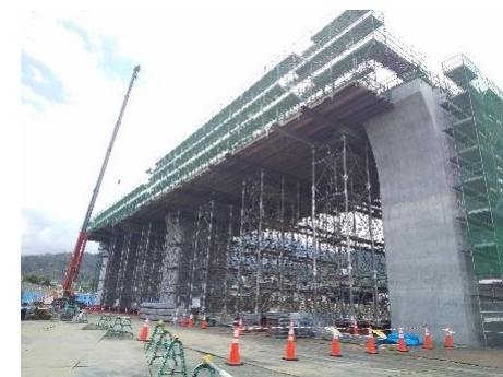
山梨県内高架橋 上部工
