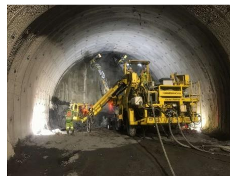
南アルプストンネル長野工区 本坑掘削工
