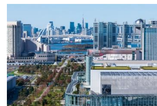
インフラ設備
