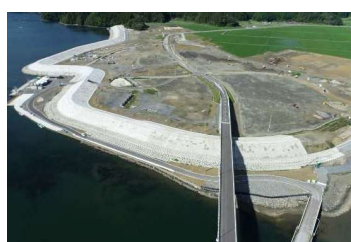
23年災長面漁港海岸保全施設災害復旧(その5)工事(宮城県)
