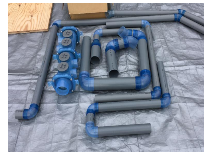
工場でのプレカット加工
