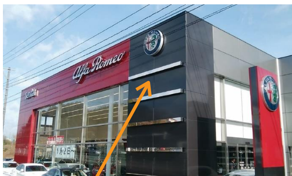
④外壁パネル (アルファロメオ店舗)
