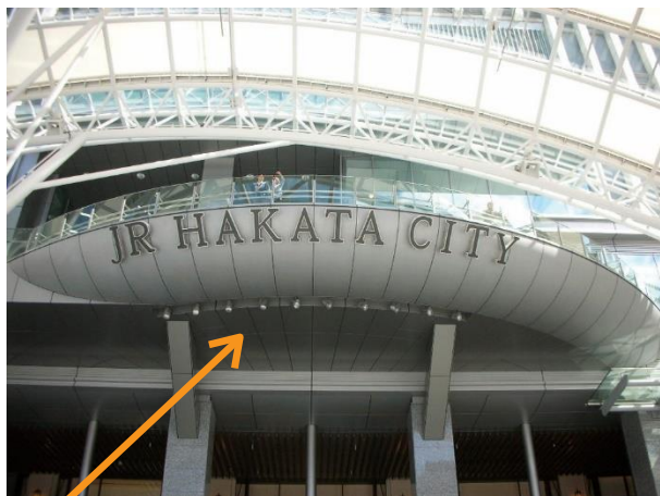
①アートパネル:外部天井パネル (JR博多駅)
