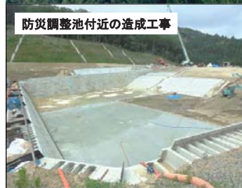
残土仮置場の造成工事
