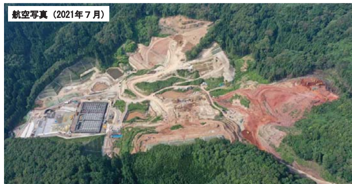
防災調整池付近の造成工事
