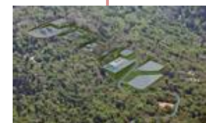
地熱 岩手県八幡平市 (安比：建設中)
