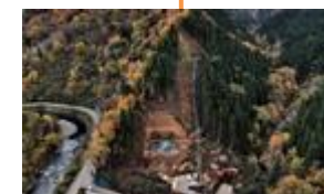
水力 秋田県北秋田市 (小又川新水力：建設中)
