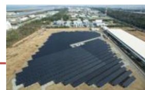
メガソーラー 福井県福井市 福井太陽光発電所
