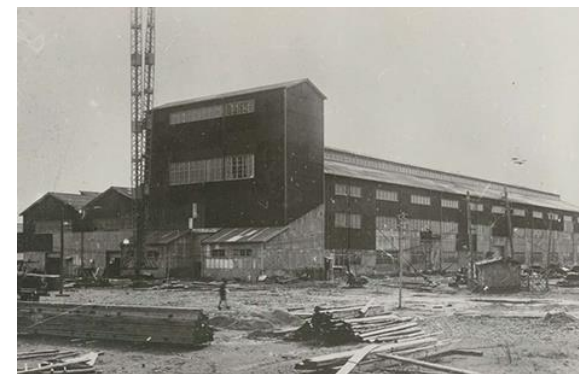
建設中の播磨工場
