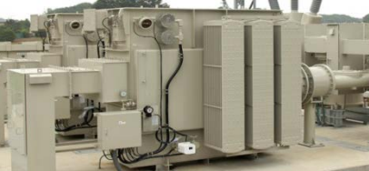
①植物由来の油を使用したパームヤシ脂肪酸エステル変圧器
