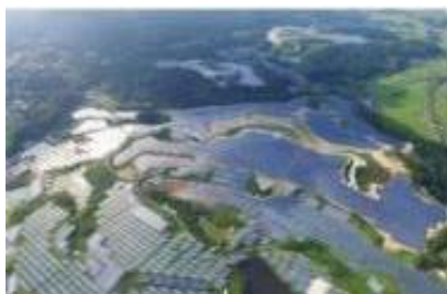
S-01 高萩太陽光発電所
