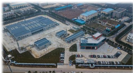
中国:電子材料ガス生産工場 俯瞰図
